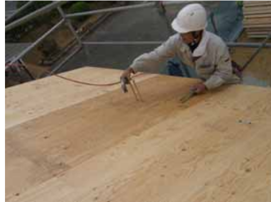
屋根パネルの組立状況
