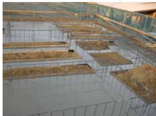
基礎ベース(布基礎)のコンクリート打設
