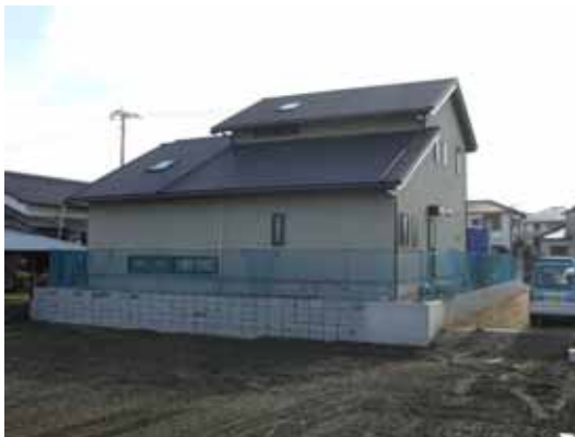
屋根・外装 外観
