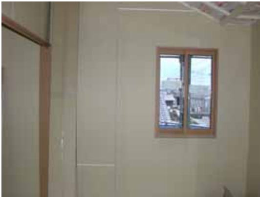
壁のボード張り状況確認
