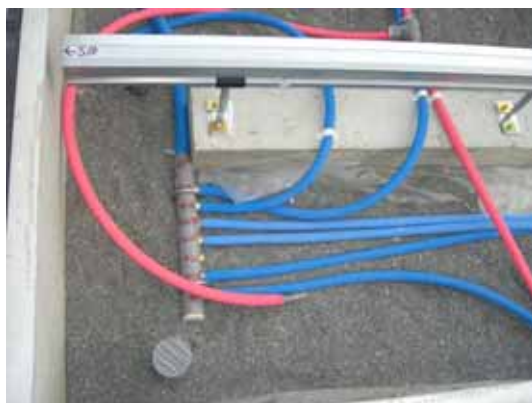
給水給湯配管状況
