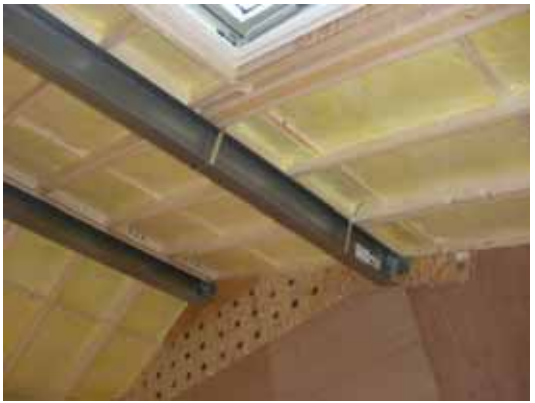
接合金物の取付状況確認
