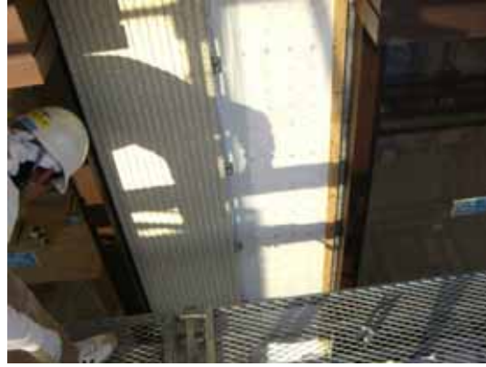
外壁 壁サイディング貼状況
