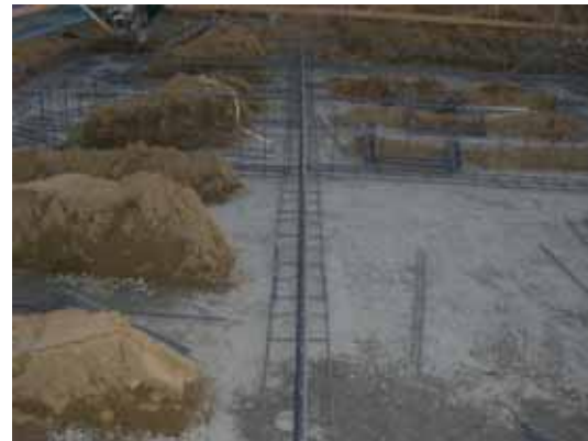
基礎ベースの配筋確認(布基礎)
