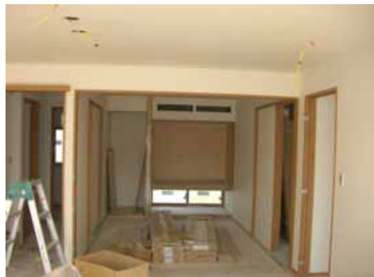
内装仕上げ工事
