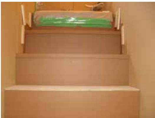
階段組立状況
