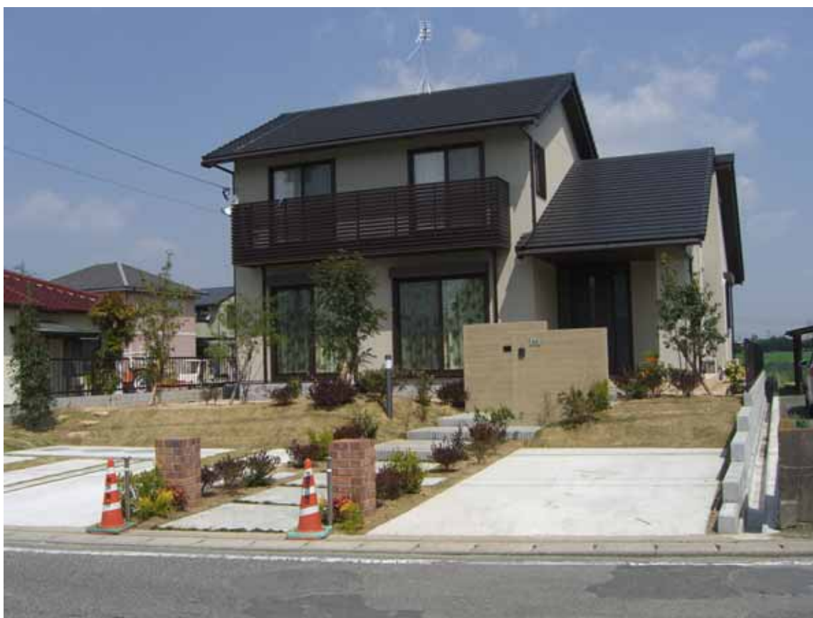
施工途中調査終了
