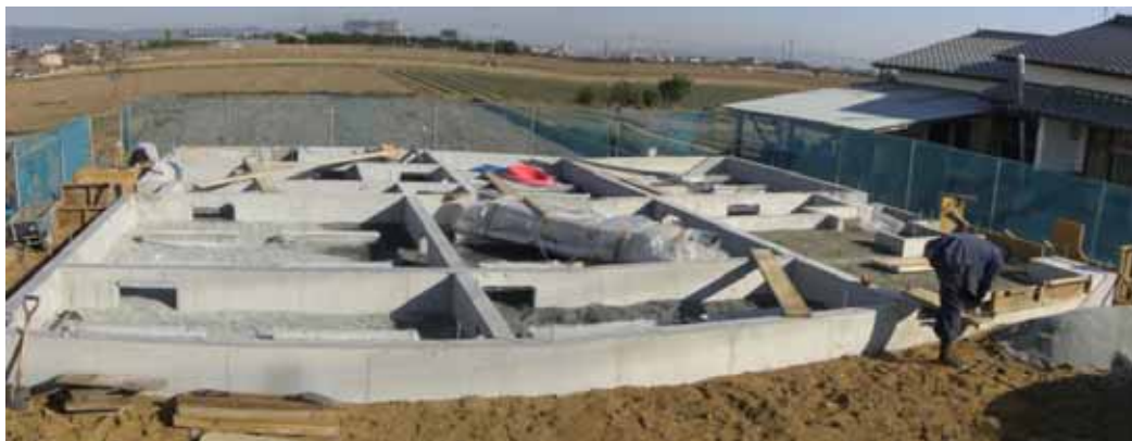
基礎の出来型確認 (布基礎)
