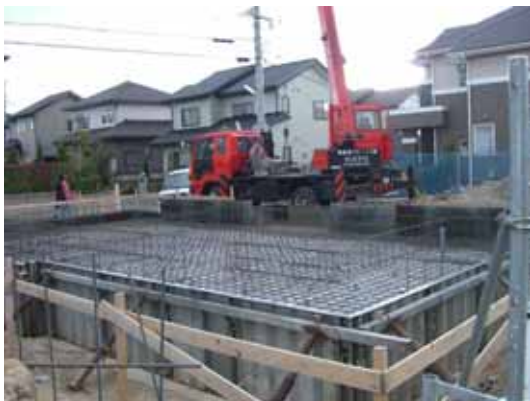
基礎ベースの配筋確認(べた基礎)
