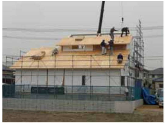
屋根の組立状況
