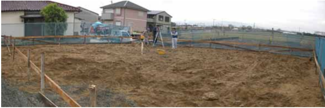
縄張り(建物の位置及び高さの決定)
