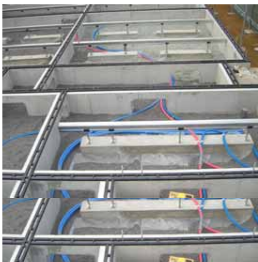
給水給湯配管状況
