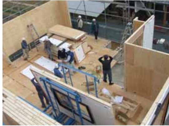
壁パネルの組立状況
