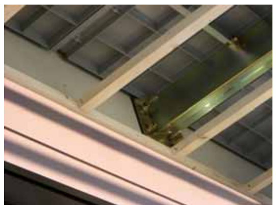
接合金物の取付状況確認
