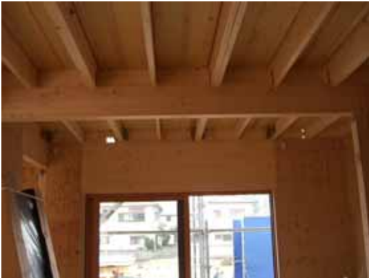
2階床の組立状況
