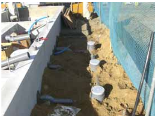
屋外排水敷設状況確認
