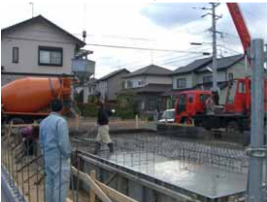
基礎ベース(べた基礎)のコンクリート打設 コンクリートの材料確認
