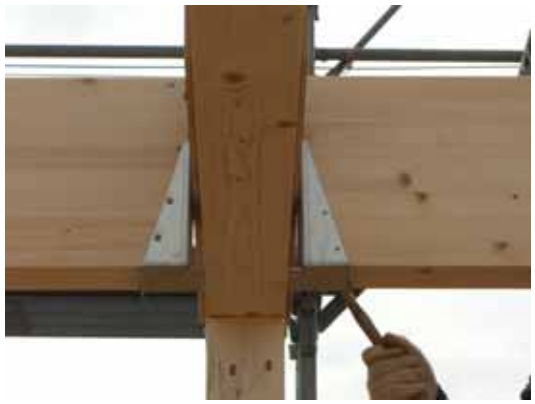
接合金物の取付状況確認
