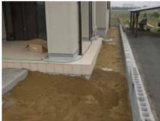
建物周辺整地状況確認
