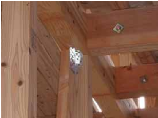
在来工法よる組立(金物取付状況確認)
