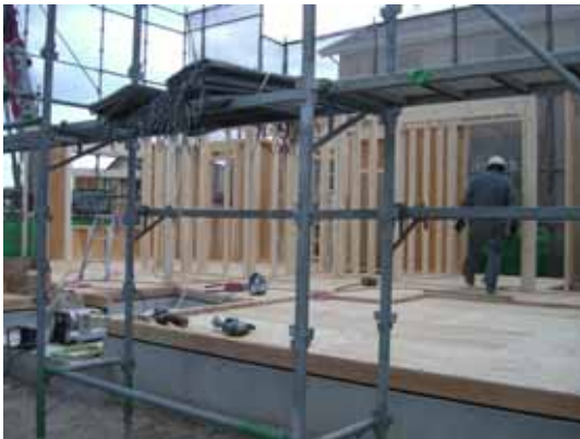
パネル工法による組立状況
