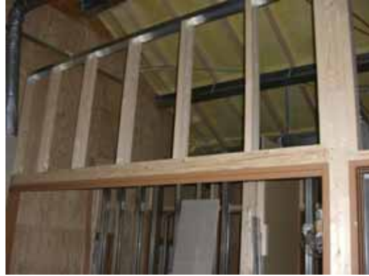
壁の間仕切状況確認
