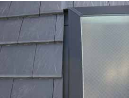
屋根天窗取合い確認
