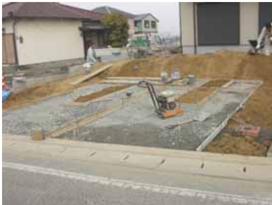
駐車場工事 砕石転圧
